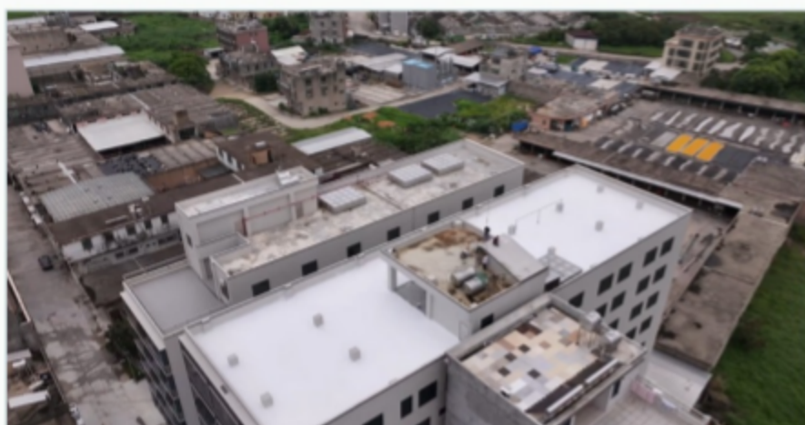
混凝土屋面整体效果
