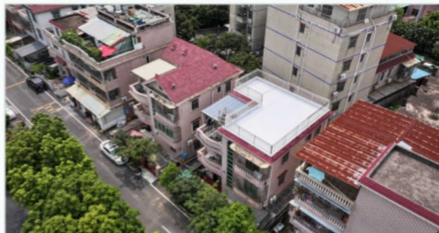
旧改屋面航拍
