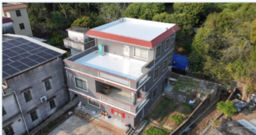
混凝土屋面整体完工
