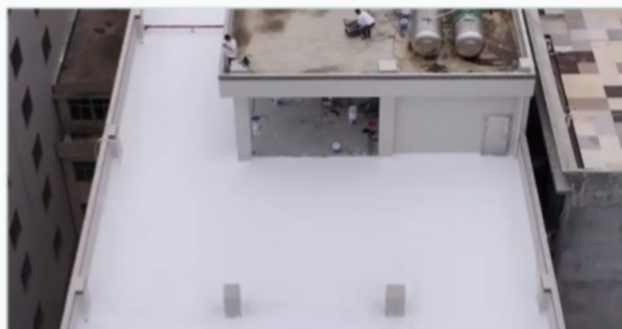
平屋面大面积完成面
