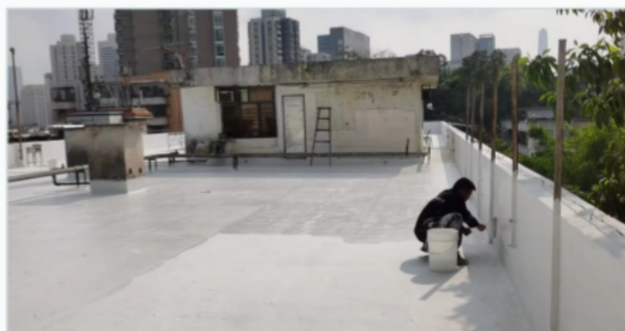
施工完成检查
